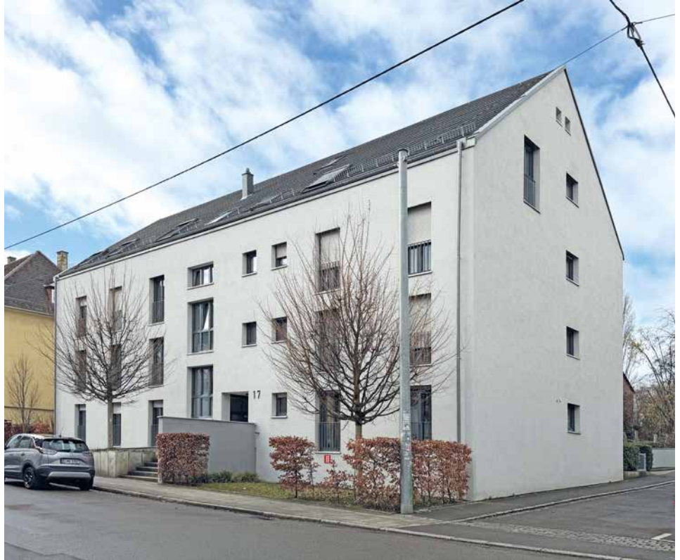
Zur BGZ gehört folgendes Gebäude: Brackheimer Straße 17, 2014 erstellt, 11 Wohnungen, rund 869 m 2 Wohnfläche
