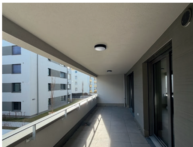
Neubau Freya Areal
